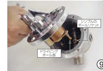
⑨ カバーに取り付けているバイメタルサーモの凸部の先端(ドライビングボール)をシンプルのボールソケット部に確実に差し込んで下さい。
